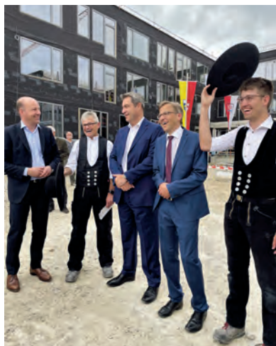
Gute Laune beim Richtfest am Rohbau des Paul-Klee-Gymnasiums in Gersthofen. Ministerpräsident Markus Söder, Landrat Martin Sailer und Schulleiter Christian Engel freuen sich mit den Zimmermännern, dass der Rohbau so schnell fertig wurde. Foto: Stadt Gersthofen
