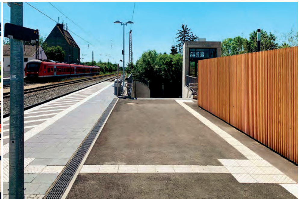
Aufzuganlagen führen barrierefrei zu den Bahnsteigen
