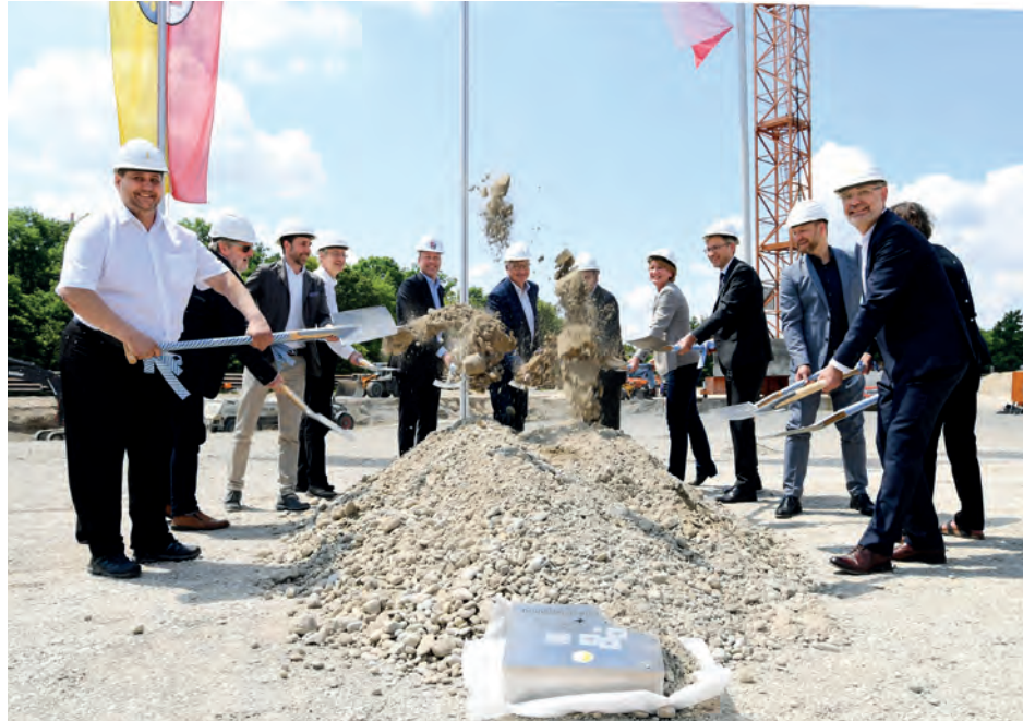
Startschuss für das größte Bauprojekt im Landkreis: das neue Paul-Klee-Gymnasium entsteht
